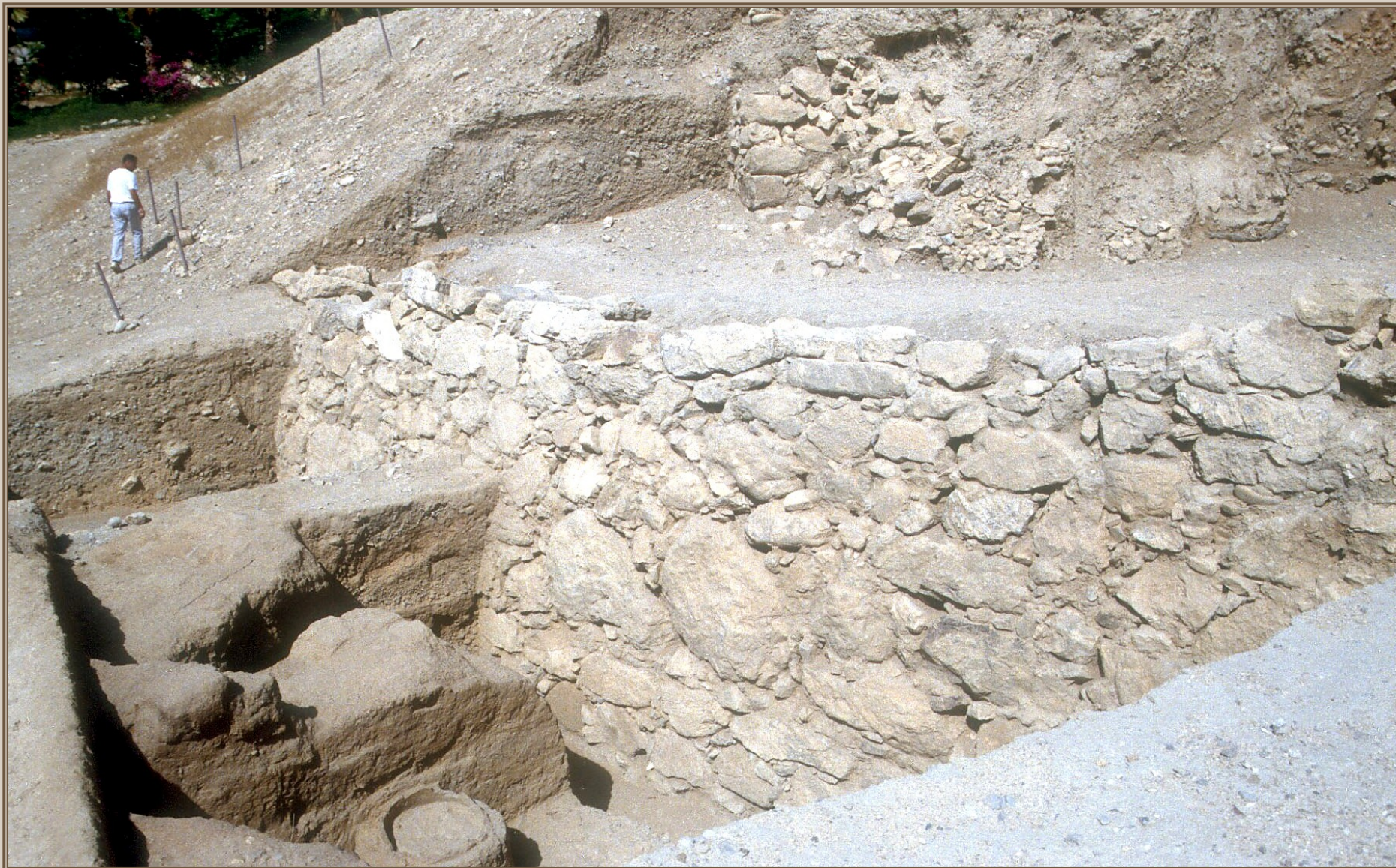
MBA Revetment Wall
