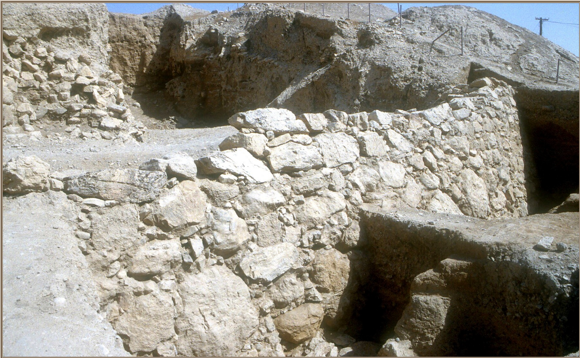
MBA Revetment Wall
